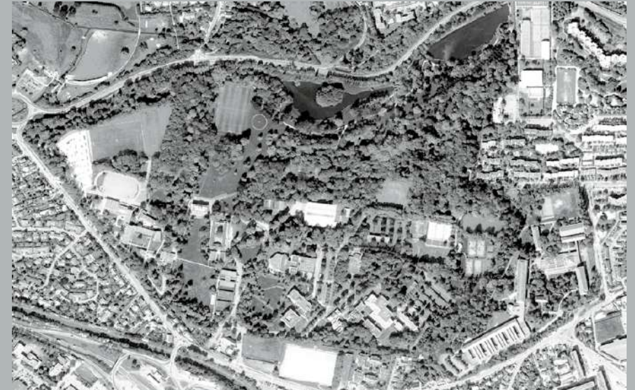
Site existant à la fin de l'exploitation Air France, 2010
